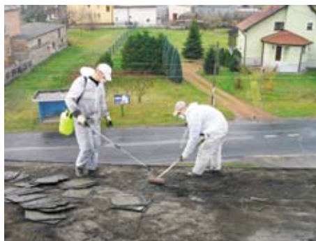
Rys. 6. Oczyszczenie terenu prac z pozostałości eternitu poprzez zmiatanie na mokro
