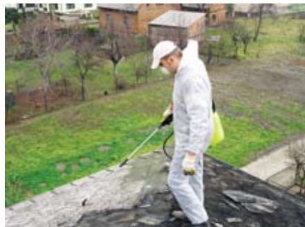
Rys. 2. Nawilżanie płytek dachu wodą za pomocą spryskiwacza
