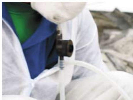
Rys. 3. Pobieranie próbek powietrza na zawartość włókien azbestu za pomocą dozymetru indywidualnego podczas pracy związanej z demontażem eternitu z dachu budynku
