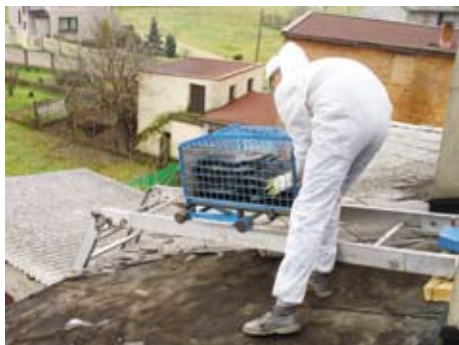
Rys. 5. Transport mechaniczny za pomocą wyciągu dekarzkiego
