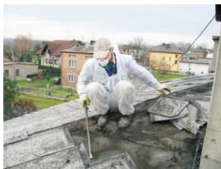
Rys. 4. Demontaż płyt eternitowych w całości za pomocą narzędzi ręcznych
